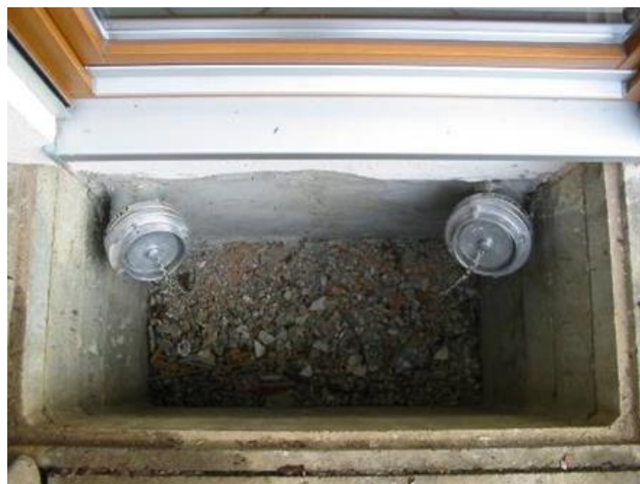
Sl. 5-32 Način punjenja spremnika peleta [Froling]
