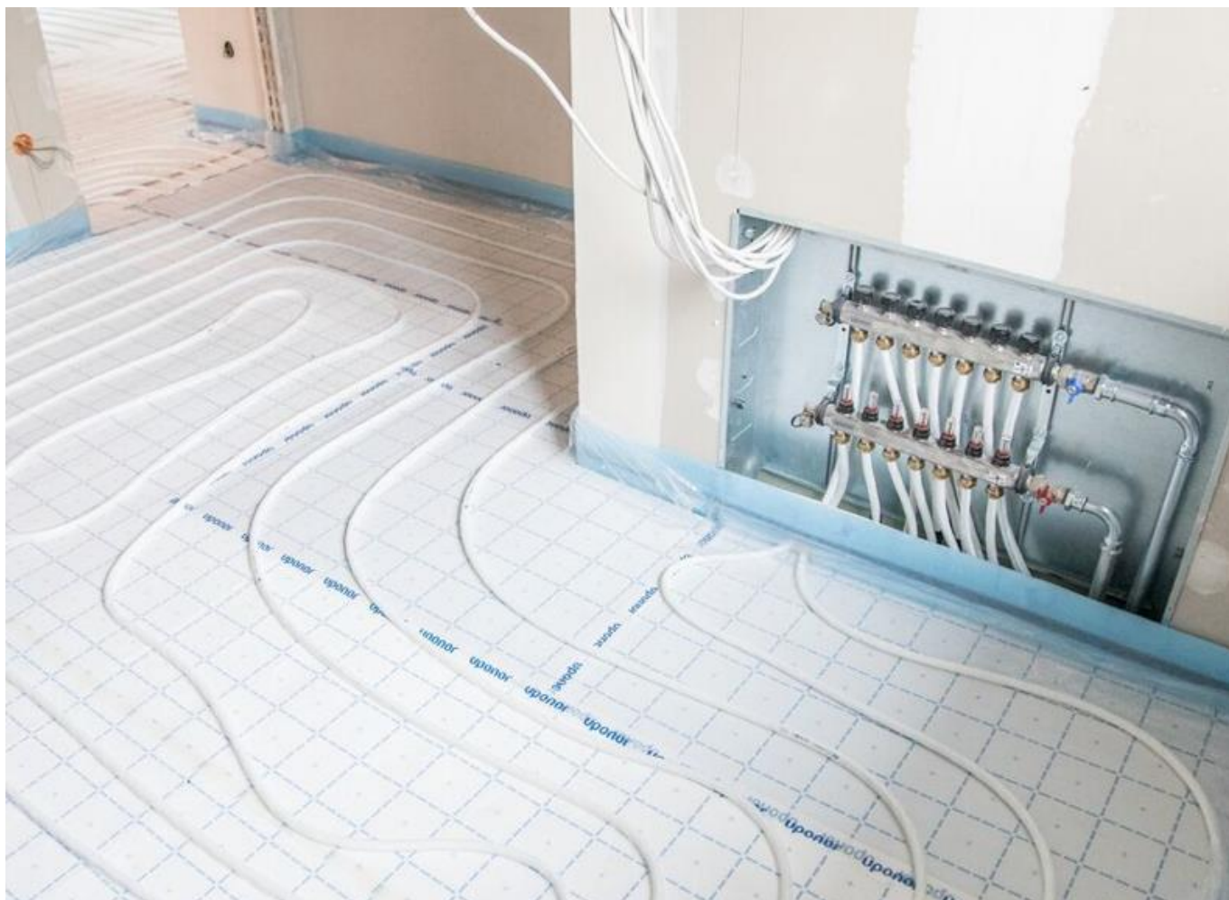
Sl. 5-55 Prikaz podžbukne ugradnje ormarića za podno grijanje [Uponor]
